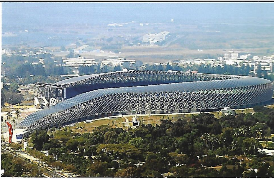
Şekil 8. Toyo Ito, Güneş Enerjili Stadyum, Tayvan (6). Figure 8. Toyo Ito, Solar Powered Stadium, Taiwan.
